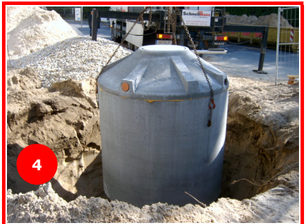
Positionierung in baureits vorbereitete Baugrube
