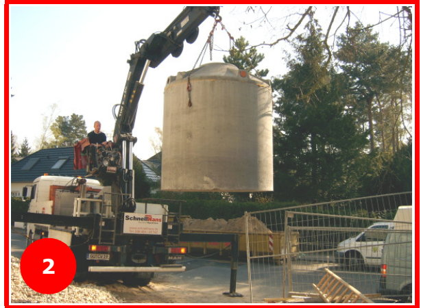
Positionierung in baureits vorbereitete Baugrube
